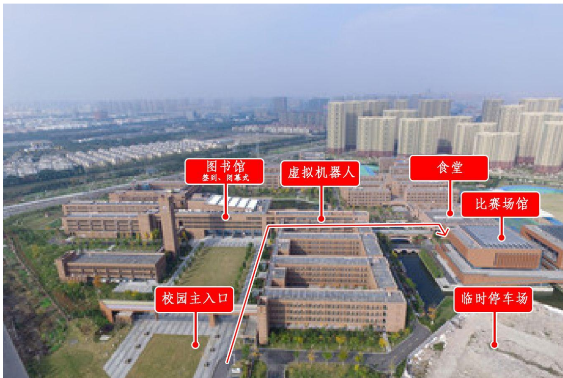
鄞州中学南门—图书馆—比赛场馆（体育馆）
