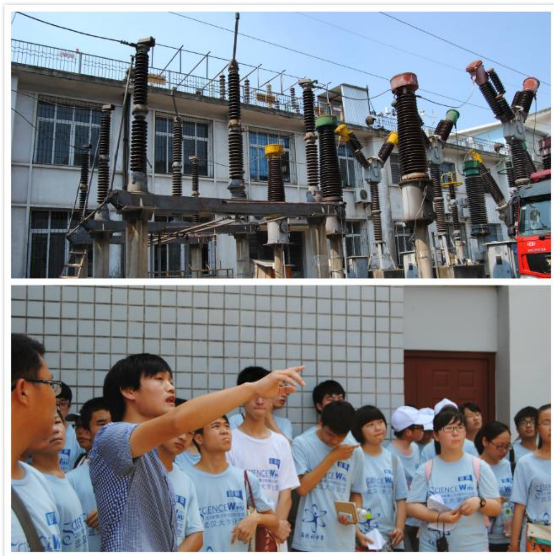
营员参观电气工程学院高压电与绝缘技术实验室
